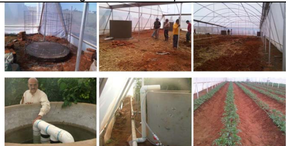
Figura 11. Invernadero abastecido con agua de lluvia y equipado con TDF con descarga controlada a cintilla
